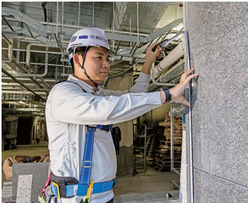
설계 수치대로 외관 석재가 적용됐는지 측정하는 현장의 모습
